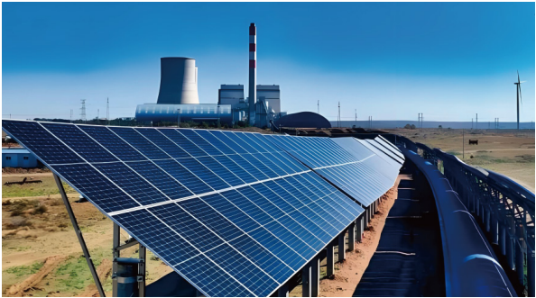
输煤廊道分布式光伏项目
