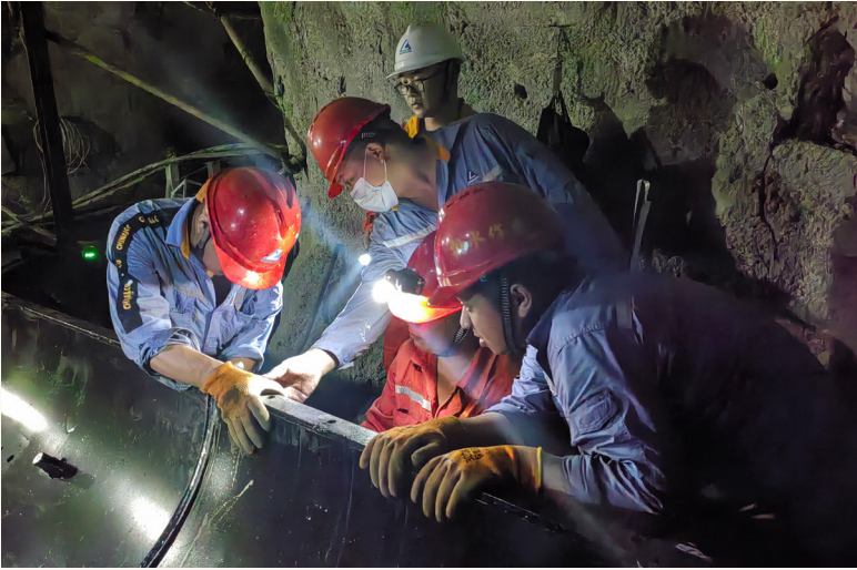
潜水泵及供电启动设备安装
