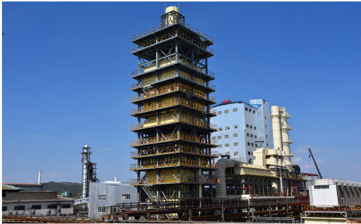
驰宏综合利用粗铅系统环境集烟设施
