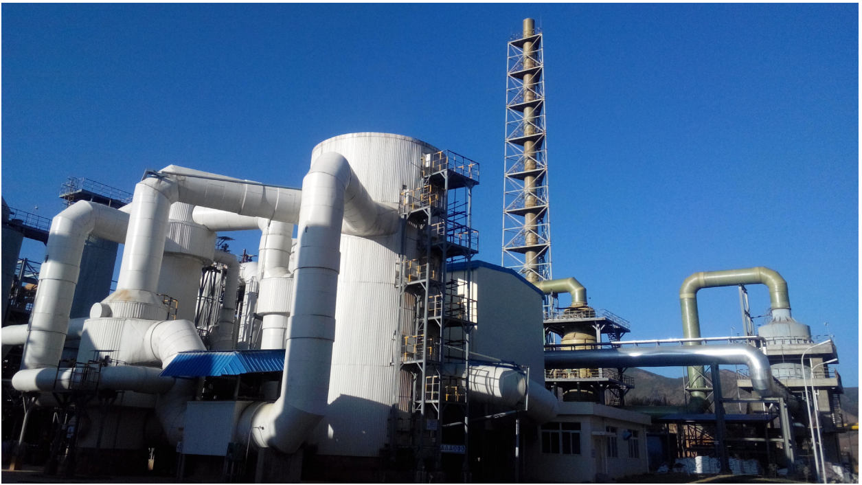
会泽冶炼设置制酸及尾气处理系统
