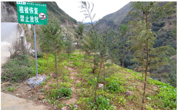
彝良驰宏投入 2,700 万余元，对整合矿业权民采时期遗留的渣石挡墙进行综合整治并恢复植被
