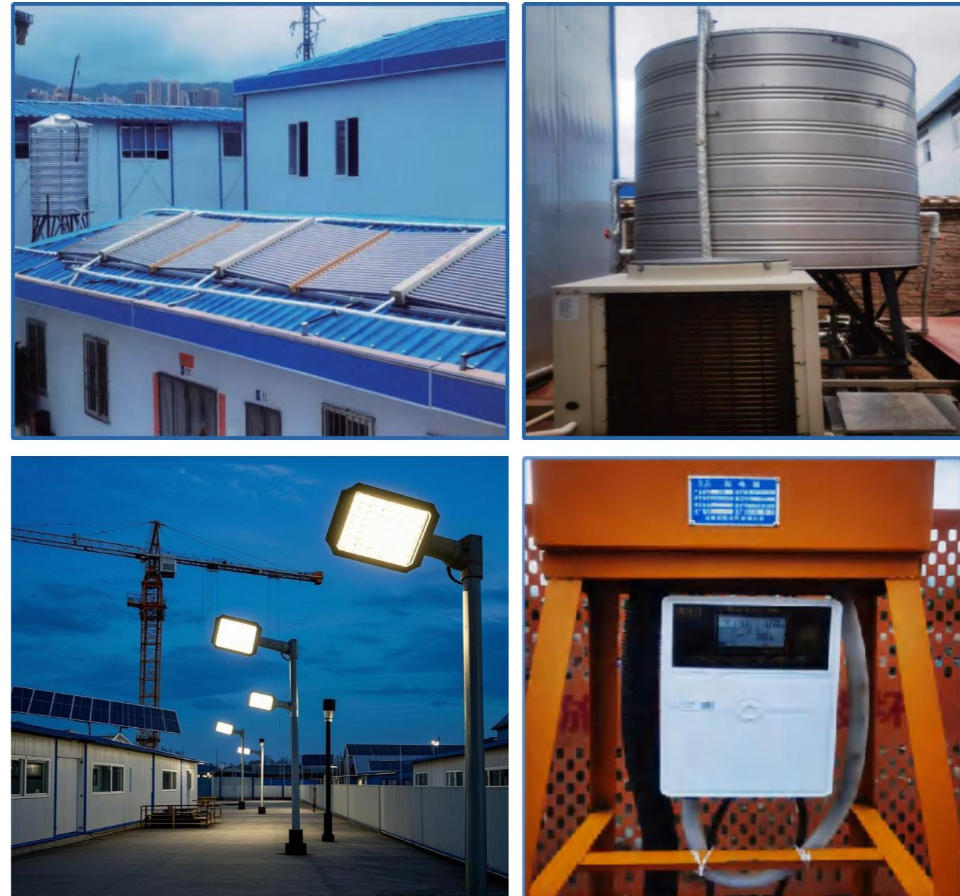
**采用节能灯：**西山区人民医院项目、和达山语项目以及润实嘉园等多个项目中，采用了智能化照明系统管理措施。这些项目在塔吊照明灯的设计上，使用的是先进的远程遥控开关技术。这一技术的应用，使得在无人加班的情况下，能够远程便捷地关闭塔吊照明灯，从而避免了因人为疏忽而导致的电力浪费。此外，项目在路灯照明方面，充分利用了清洁可再生的太阳能资源。太阳能路灯不仅降低了电力消耗，还减少了对传统能源的依赖，体现了绿色建筑的理念。
