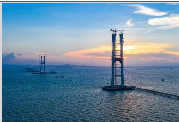
一体化智能筑塔机应用于深中通道伶仃洋大桥
