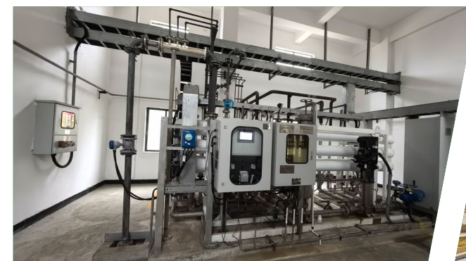
➤➤ 废水零排放反渗透装置
