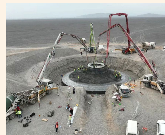
新疆公司托克逊风电项目全部风机基础浇筑完成
