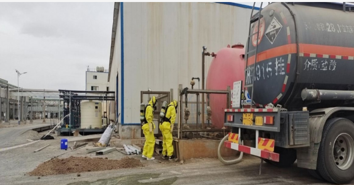
紧急关闭盐酸储罐漏点阀门
