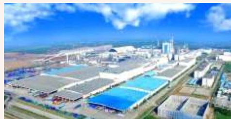
• 湛江晨鸣化学浆项目
