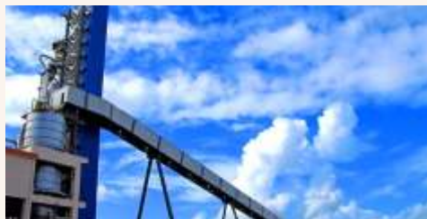
• 湛江晨鸣化学浆项目
