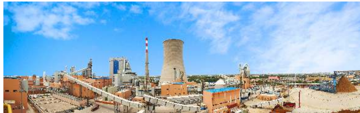
寿光晨鸣100万吨化学浆全景图
