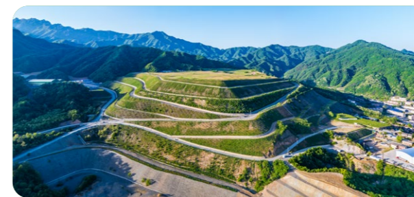
复垦后的北沟排土场
