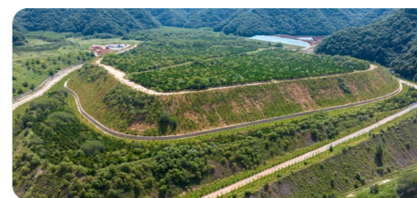
金堆城钼矿马路沟排土场
