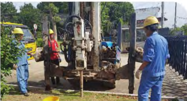
土壤隐患排查
