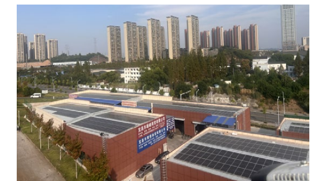
物流园区屋顶分布式光伏项目
