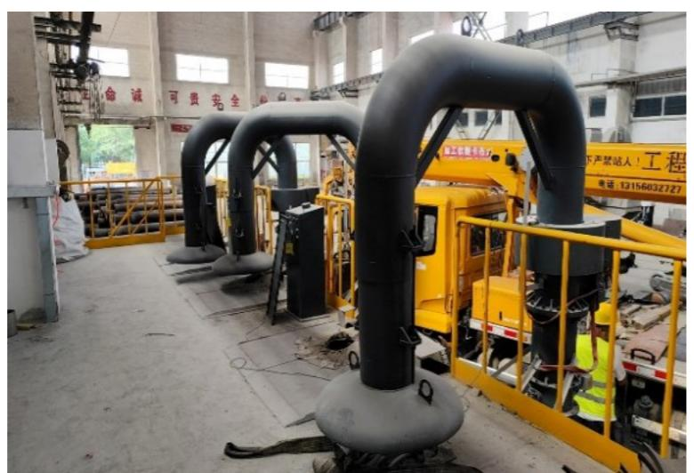
新力通升级可旋转调整除尘系统，减少烟尘漂浮，提高除尘效率
