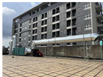
封胶、固晶、烤箱废气治理设施
