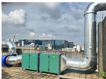
回流焊、波峰焊废气治理设施
