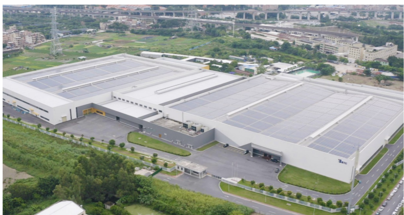
屋顶光伏发电系统
