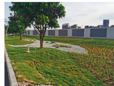
海绵城市建设项目实施现场
