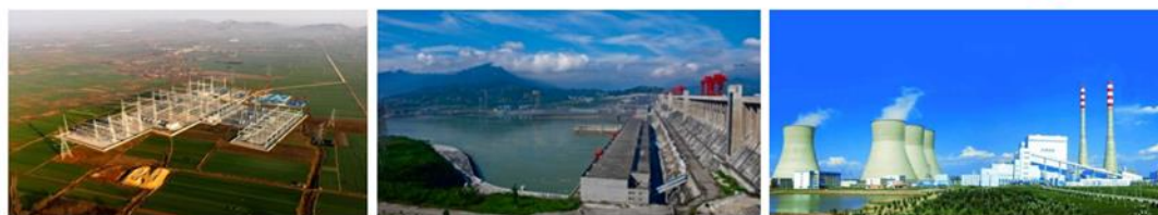
直流电源系统@1000kV特高压晋东南变电站
