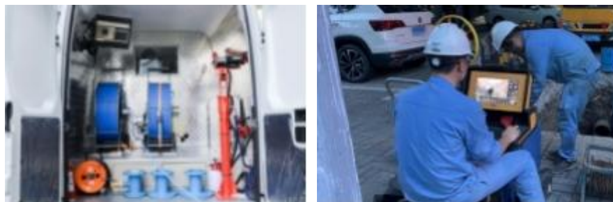
图9 管道检测工程案例
