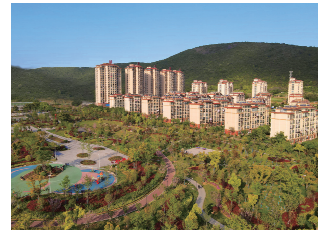
公司棚户区改造部分实景
