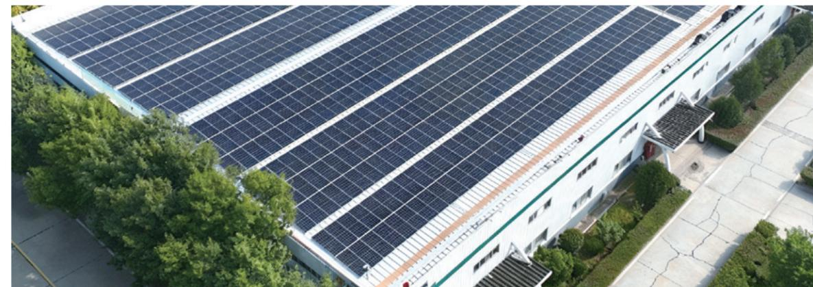
8 家下属企业安装分布式光伏机组，总装机容量达到 14.09MW，年均输出清洁电能 1,570 万 kWh
