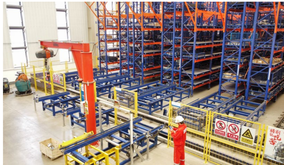
“云仓储”立体库—入库口
