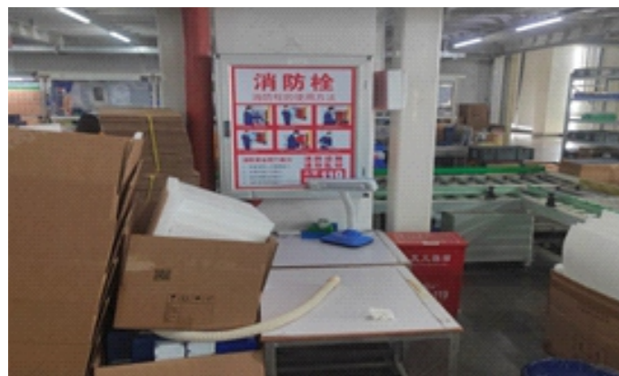
安全隐患排查前
