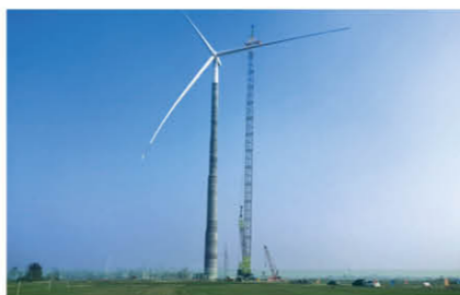
▲ 利辛南部 100MW 风电项目风机吊装图
