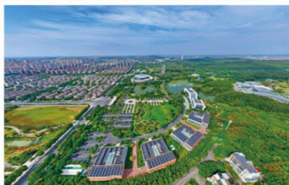
▲ 山南办公园区综合新能源项目鸟瞰
