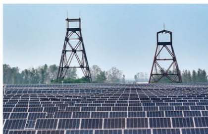
▲ 原新集五矿分布式光伏项目俯瞰图
