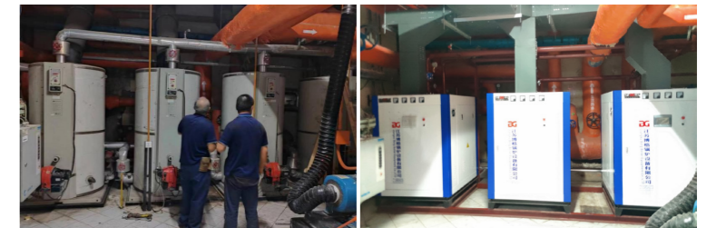
锅炉改造前后
