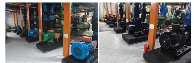
循环水泵改造前后
