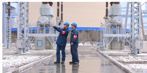
▶ 托克托发电公司以常态化巡检保障电力可靠供应
