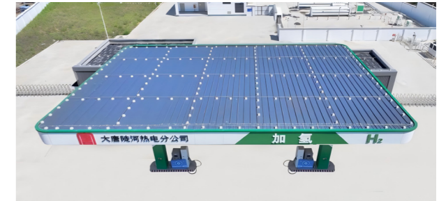
▶ 大唐国际第一座制氢加氢站
