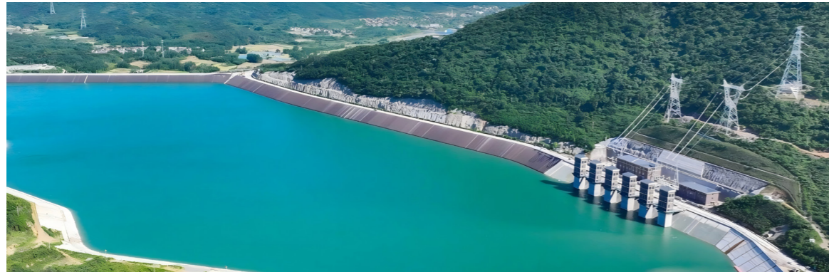
▶ 武隆银盘抽水蓄能电站
