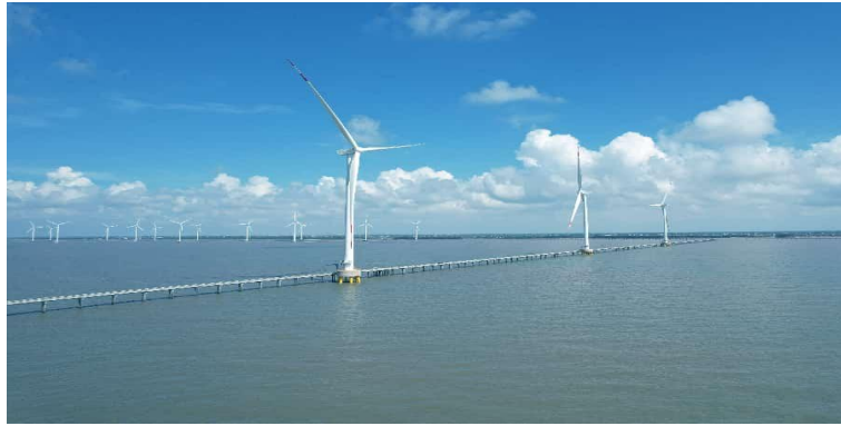
越南薄寮三期海上风电项目
