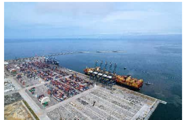
喀麦隆克里比深水港二期项目
