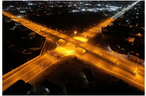
中毛友谊立交桥项目
