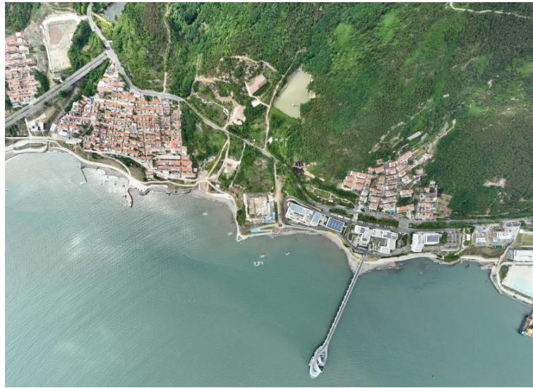
山东青岛小岛湾北岸海岸带综合整治工程项目
