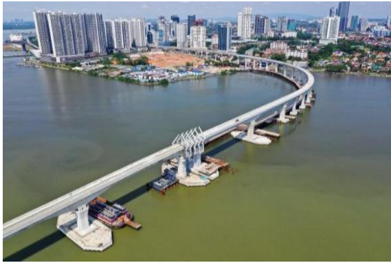
新加坡新柔捷运 T235 项目
