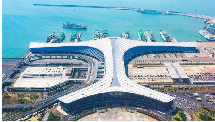
海口新海滚装码头客运综合枢纽站：全国最大的港口客滚综合枢纽，荣获钢结构领域最高荣誉“中国钢结构金奖”
