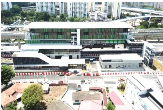
马来西亚吉隆坡地铁 2 号线项目
