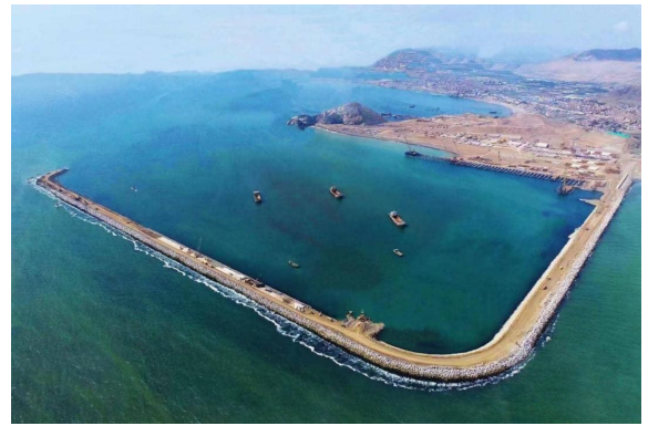
秘鲁钱凯港项目
