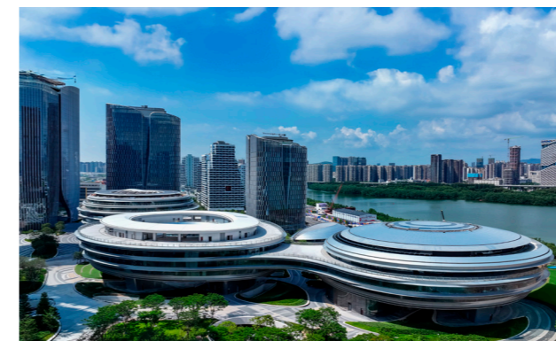
深圳大铲湾DY01-04街坊云楼
