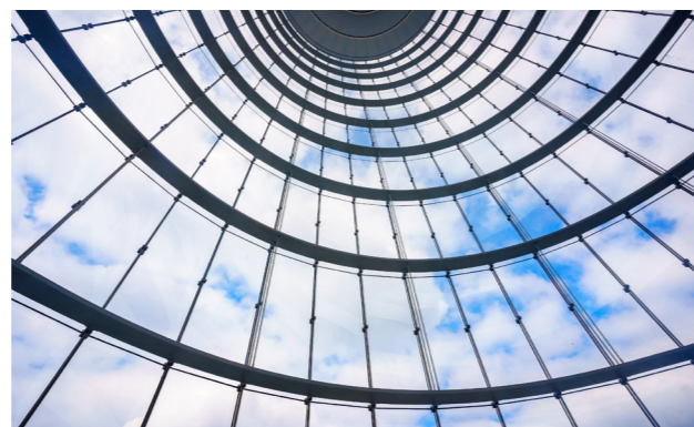
超大高钢索幕墙设计与施工应用
