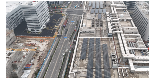
宁波北仑 246 基地 399.26KW 光伏建设
