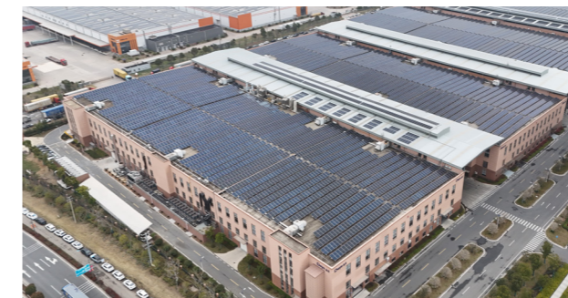
宁波龙山基地 6MW 光伏建设
