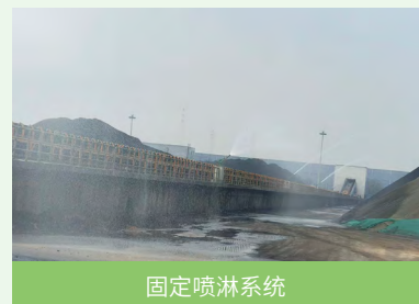
喷洒环保型结壳剂或润湿型抑尘剂
