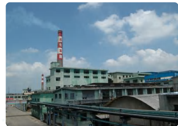
公司工厂锅炉
