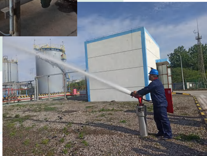
VCM球罐底部出口法兰垫子泄漏事故应急演练
