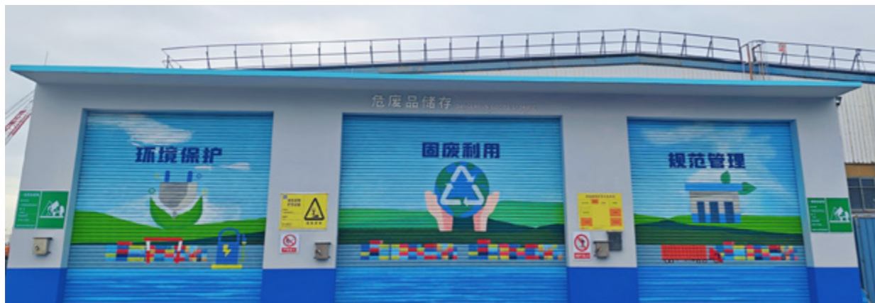
危废品储存站
