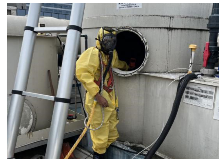
▲ 废气塔深度清理
