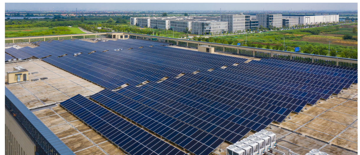
▲ 宁夏晶环屋顶光伏
