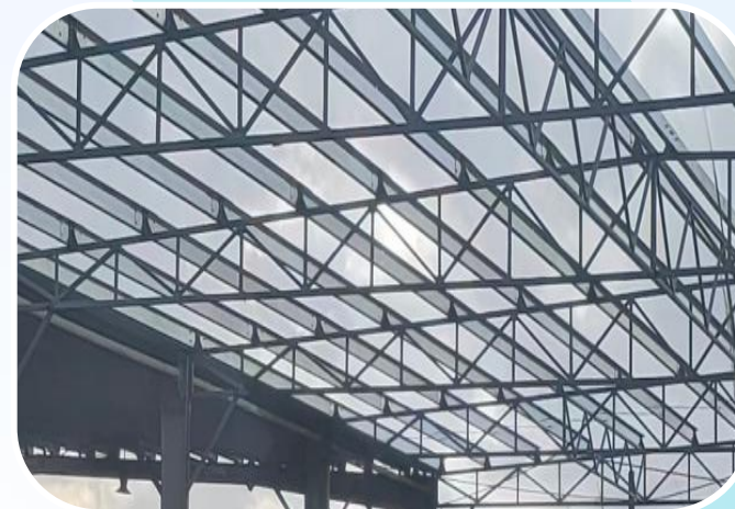
图：公司厂区二期光伏电
