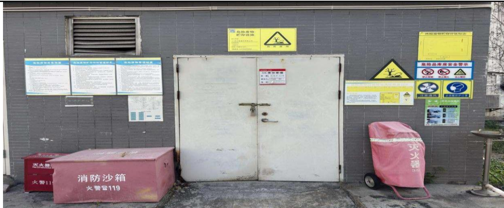
成员企业深圳市中诺通讯有限公司危废仓库及消防设施
