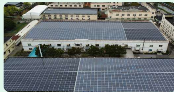
本厂1118KW屋顶光伏项目
