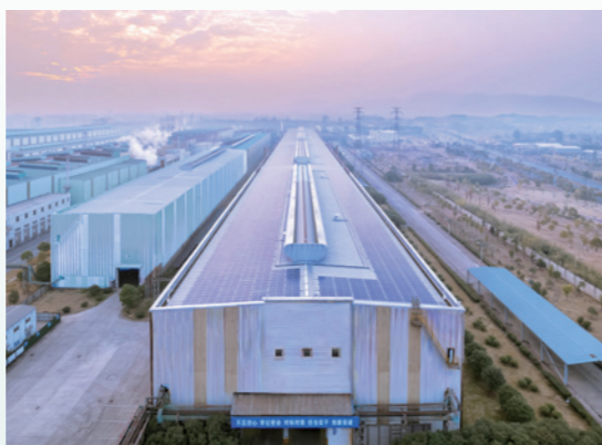
光伏发电厂房
