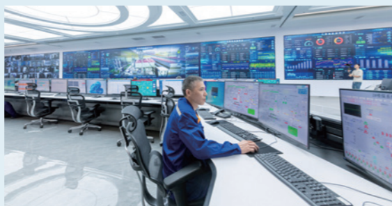
铁前工序智慧集控项目顺利投运并通过全流程验收，实现从“分散操控”到“集中智慧管控”的跨越式升级。
