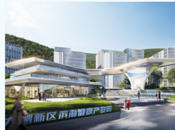
▲ 特区建工集团大鹏新区优质产业空间试点项目 (EPC)
