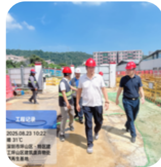
▲ 能建集团开展安全生产隐患排查
