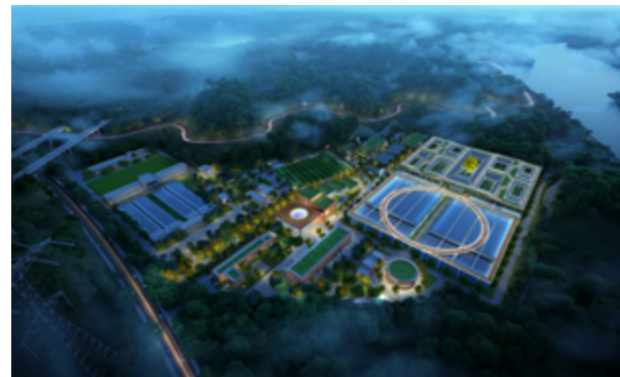
▲ 沙湾二水厂二期扩建（含深度处理）工程施工总承包
