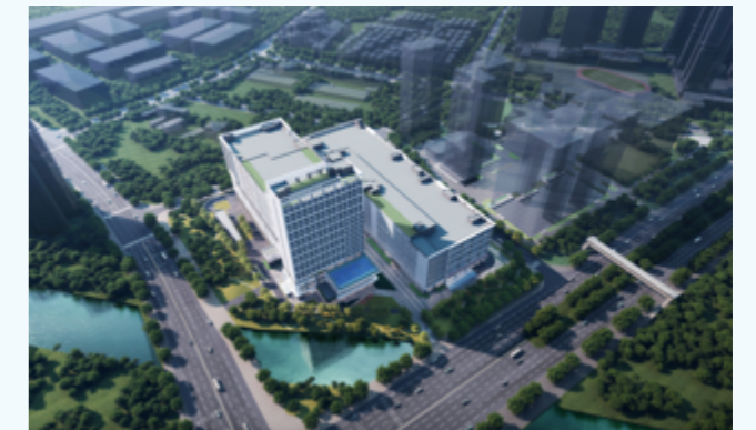
▲ 塘家社区返还用地项目 EPC (设计施工一体化) 工程
