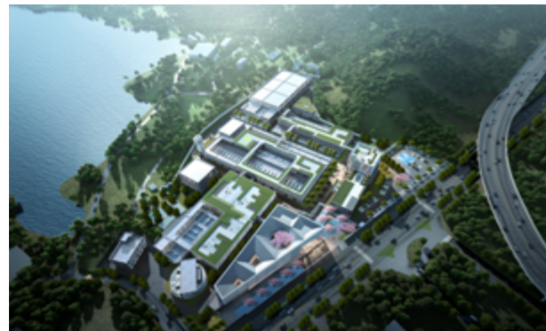
▲ 深圳东湖水厂扩能改造工程设计采购施工总承包 (EPC)
