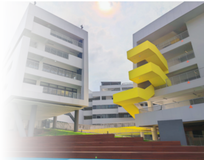
▲ 观澜第二小学改扩建工程
