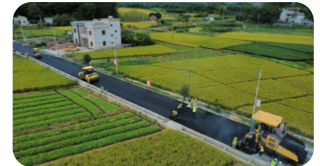
▲ 深汕道路施工现场
