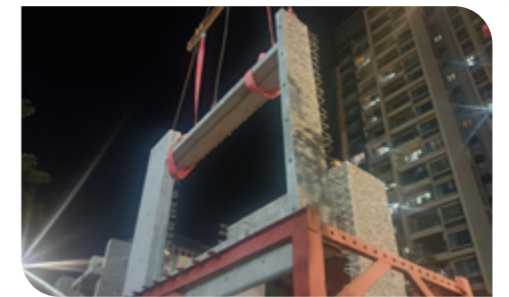
▲ 预制凸窗平衡梁吊装
