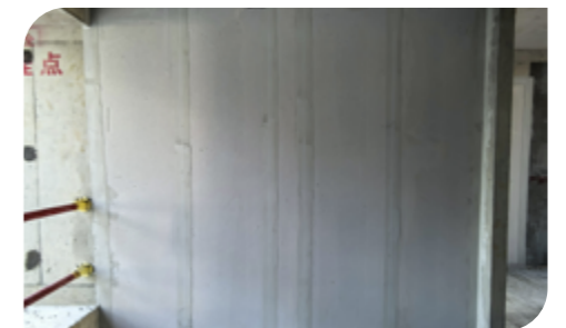
▲ ALC 板排版安装
