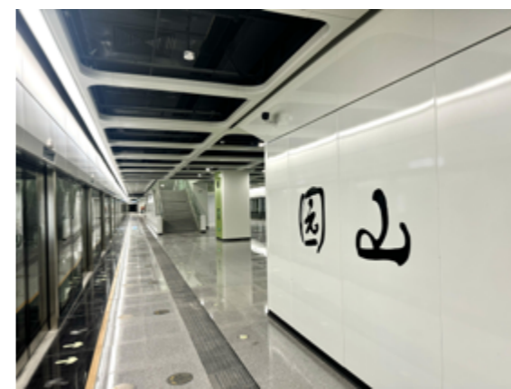
▲ 深圳市城市轨道交通 16 号线二期工程
