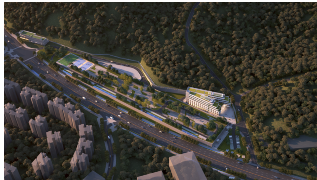
▲ 深圳市城市轨道交通 17 号线一期 17103 标施工总承包工程
