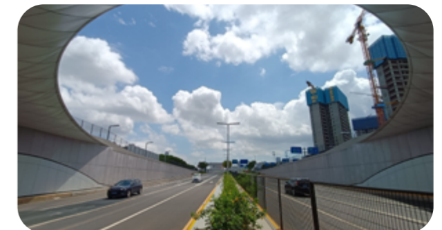
▲ 前海地下道路
