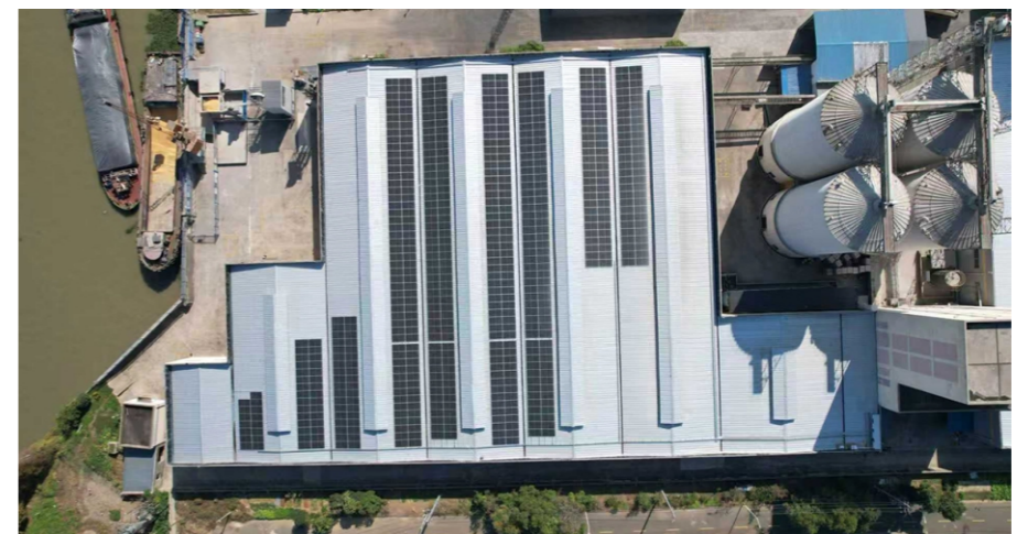
常州天牧饲料厂光伏项目
