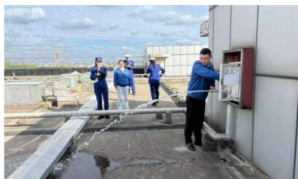
消防双随机检查
