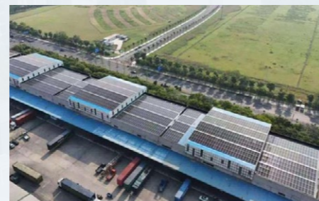
物流公司光伏项目
