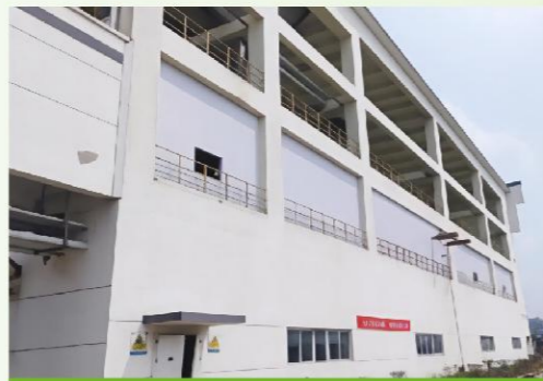
氯化钙厂房封闭
