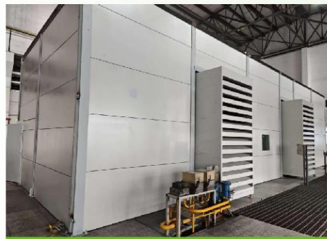
锅炉（汽轮机）封闭降低噪音项目
