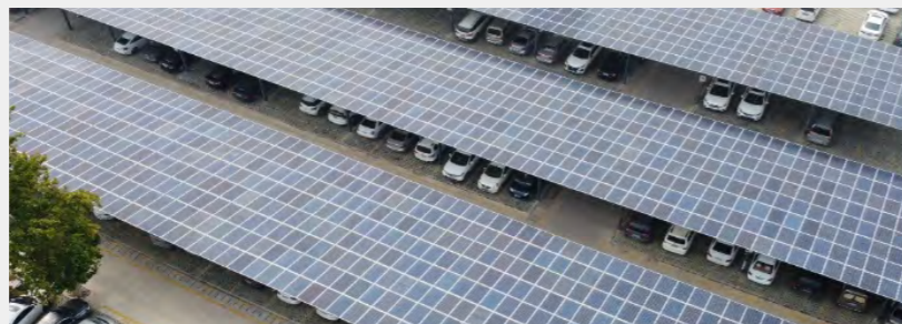
1.8MW 光伏车棚
