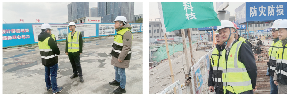
元旦前建筑施工专项隐患排查
