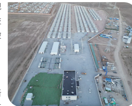
内蒙古自治区某500MW/2000MWh独立新型储能建设项目
