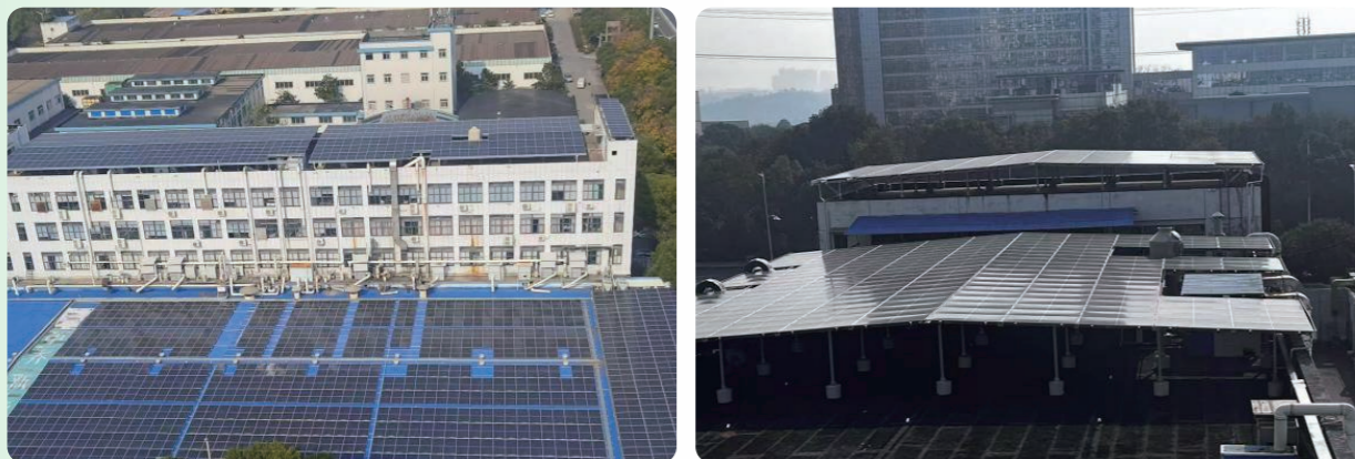
光伏发电设施建设
