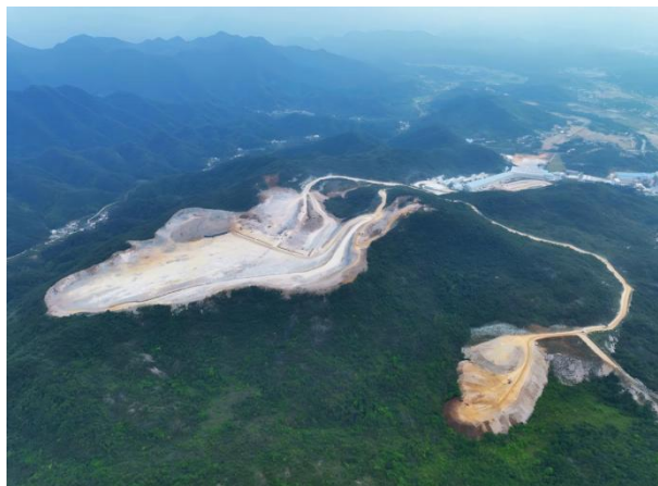
安徽省石台县坑电石用灰岩矿石料开采加工总承包项目
