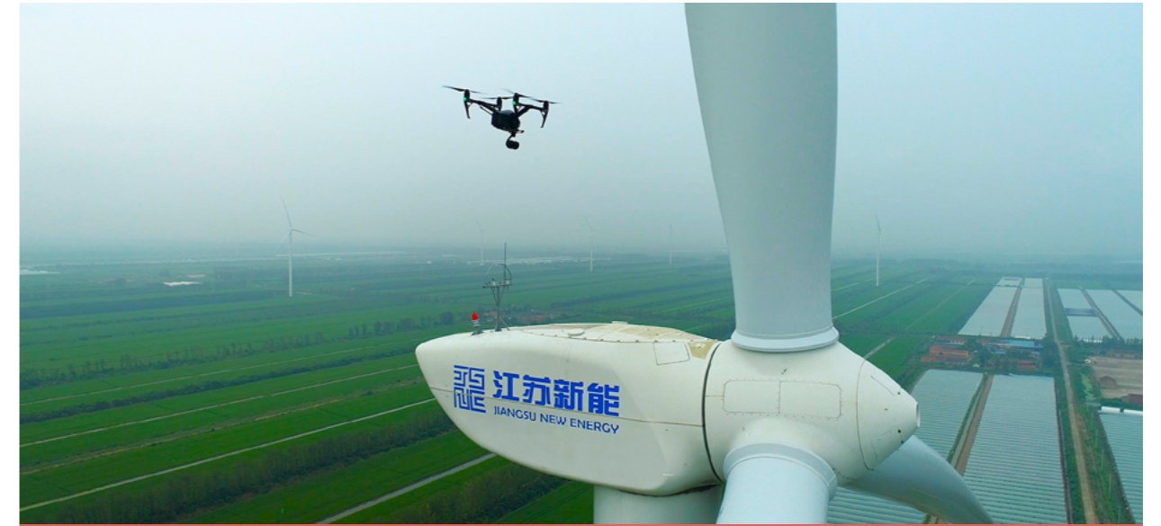
临海风电叶片无人机巡检
