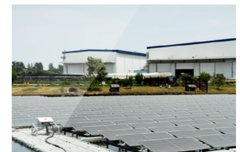
水上漂浮式光伏示范项目
