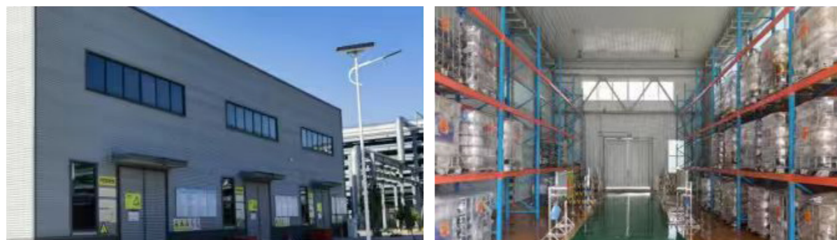
危险废弃物暂存库外景和内部
