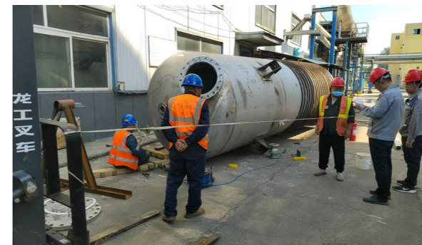
现场安全检查
