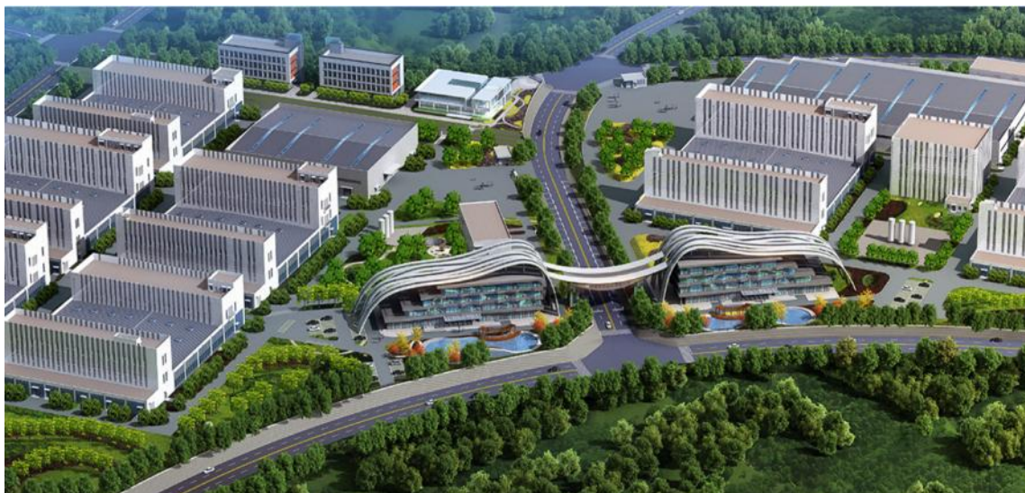
百利锂电承揽建设的全球首家“零碳”正极材料生产基地
