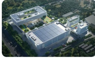
武汉海微科技股份有限公司 1.海微车载智能座舱研发产业化基地项目（一期） 洁净装修工程
