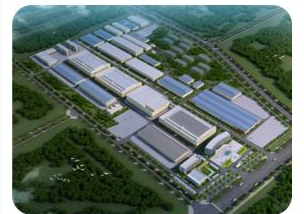
湖北中一科技股份有限公司 中一五期空调净化系统
