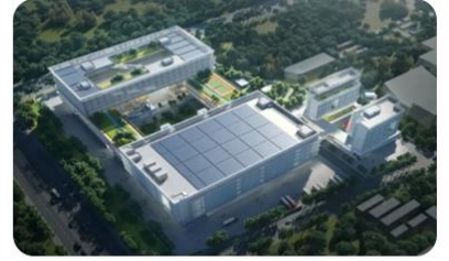
武汉海微科技股份有限公司 2.海微车载智能座舱研发产业化基地项目（二期） 洁净装修工程
