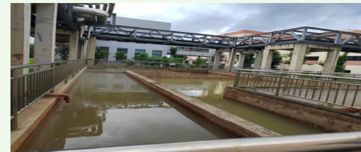
凝结水回用改造项目
