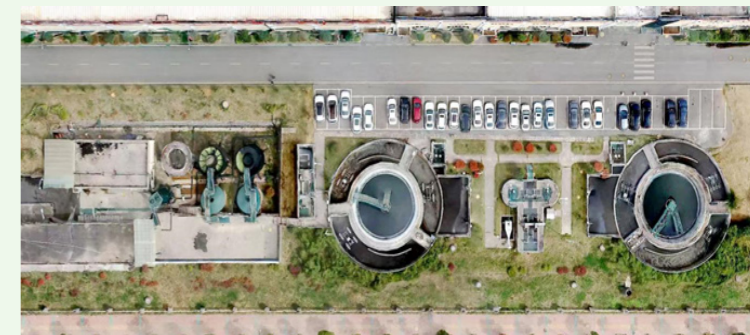
国内工厂污水处理设施
