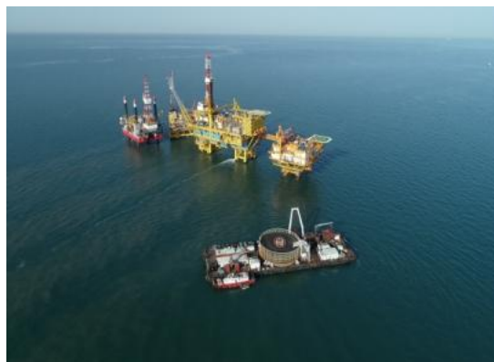
渤海秦皇岛-曹妃甸油田群岸电项目
