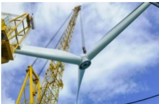
亨通浙能台州 1 号海上风电项目风机安装工程
