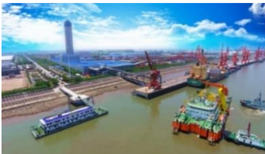
亨通国家电网舟山项目
