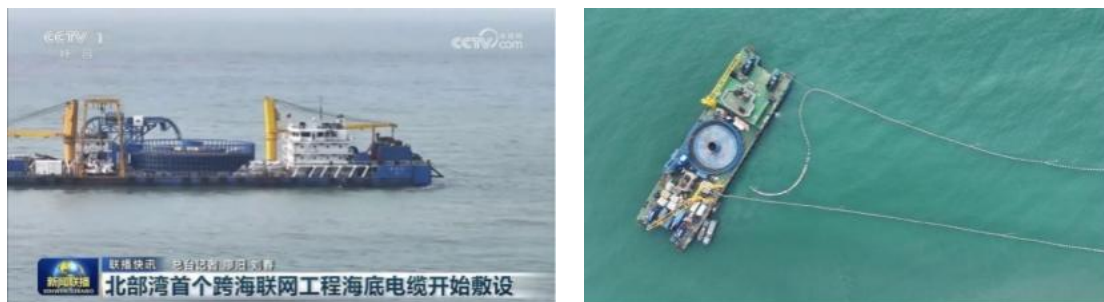
亨通参与的“220kV 涠洲岛跨海联网工程”海缆敷设
