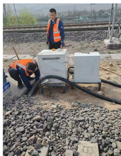
完成中煤线筒仓道岔吹雪设备现场安装
