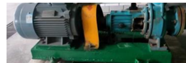
空压站冷却水泵改造
