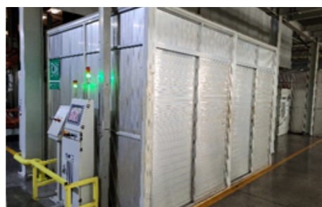
噪声源封闭管理
